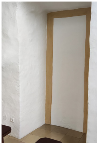
Vermauerte Eingangstür in die einstige Totenkapelle des Karners
